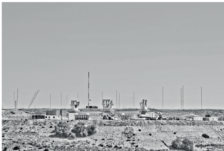
Il cantiere Muos, 2 Luglio 2013, foto di Glauco Canalis.
